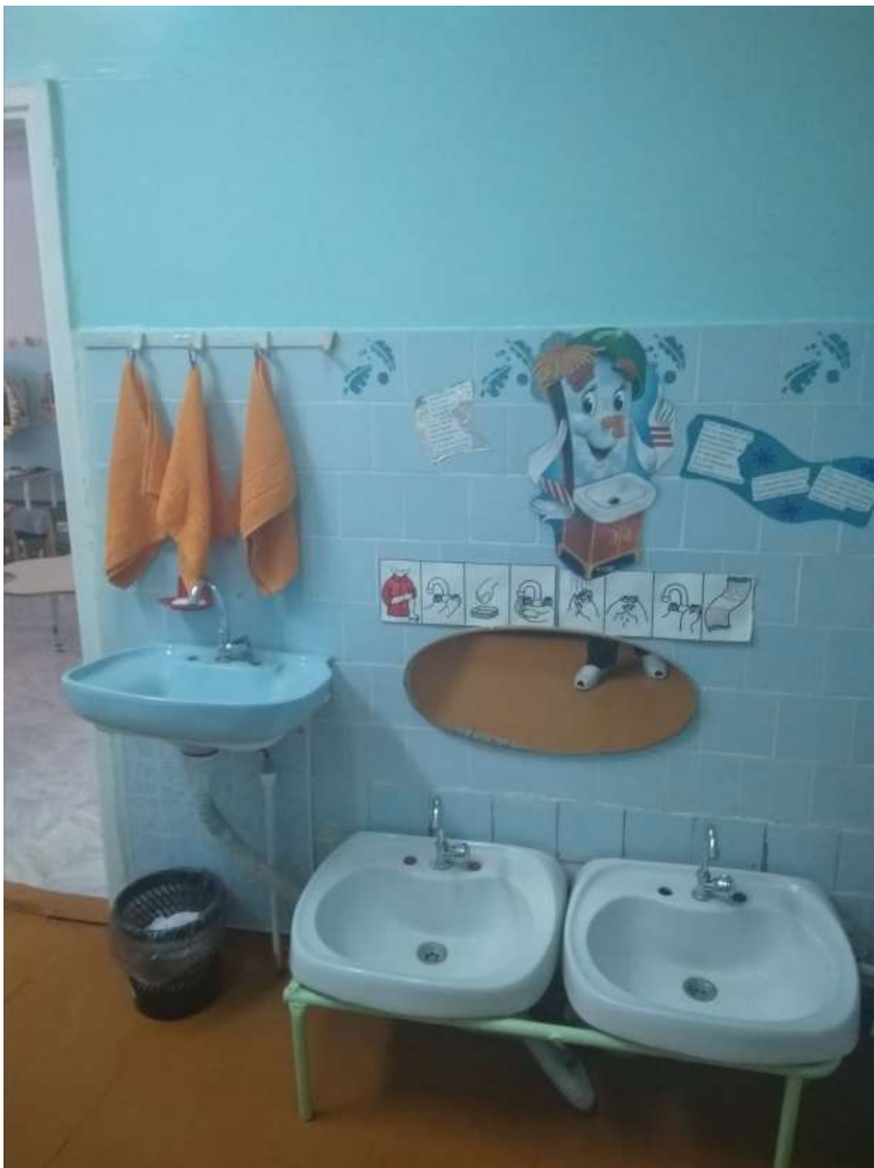
Фото 14. Санитарно-гигиенические помещения: умывальная комната
